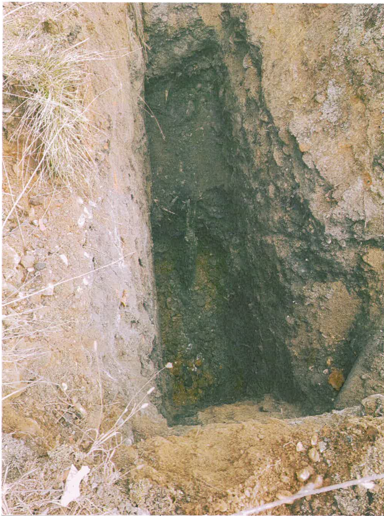
Imaginea 3. - Excavația 2 - șăruș de lemn în talpa excavației și în peretele din dreapta
